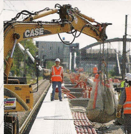
Les travaux de rehaussement des quais.
