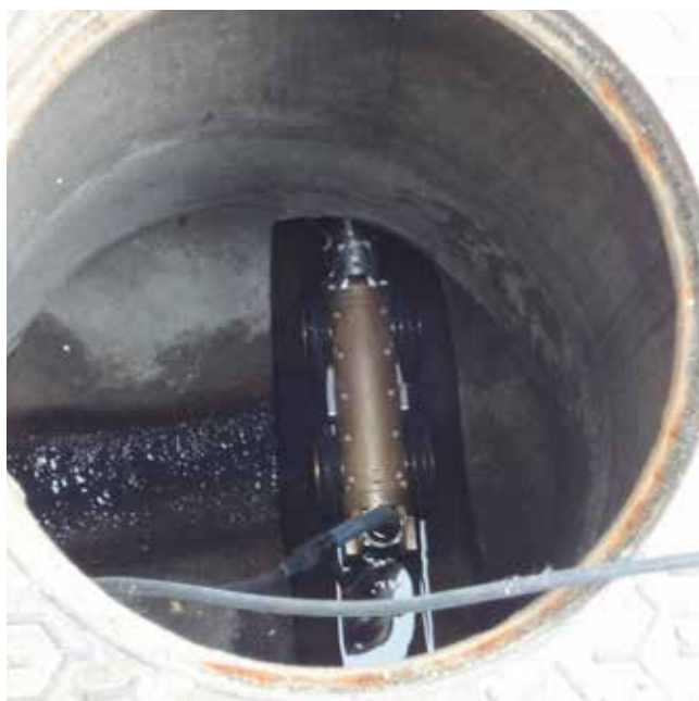
Inspection télé d'une canalisation à l'aide d'un robot. © Conseil général de la Seine-Saint-Denis.
