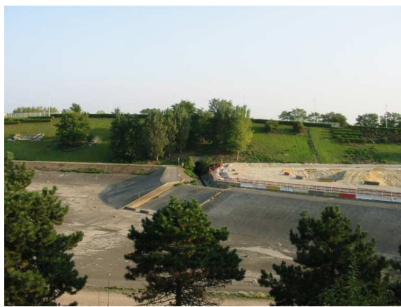
La présence de grands bassins de rétention indique que le site doit pouvoir stocker de grande quantité d'eau pour compenser l'imperméabilisation des sols limitrophes
